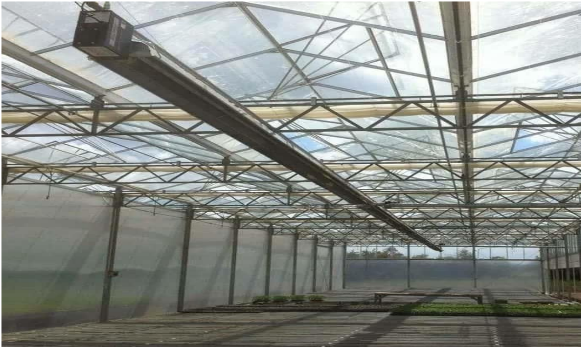
Рисунок 1. Обогрев теплицы инфракрасным обогревателем.
