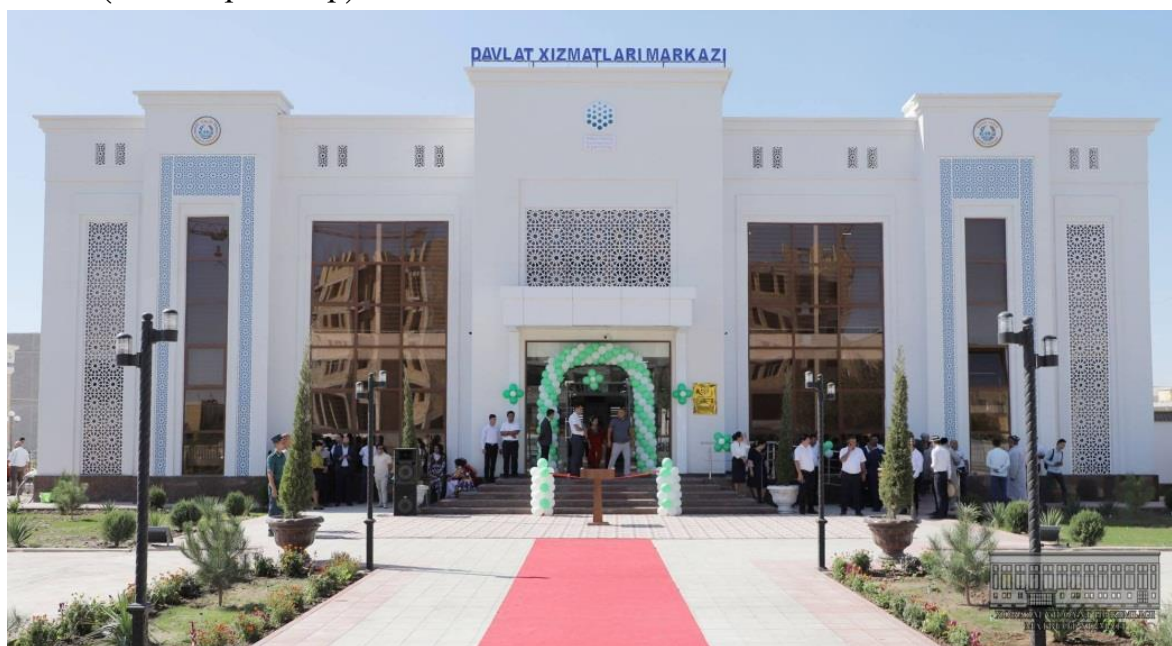
1-расм. Хоразм вилояти Урганч шаҳар марказида жойлашган Давлат хизматлари агентлиги маркази биносининг тарз лойиҳаси
