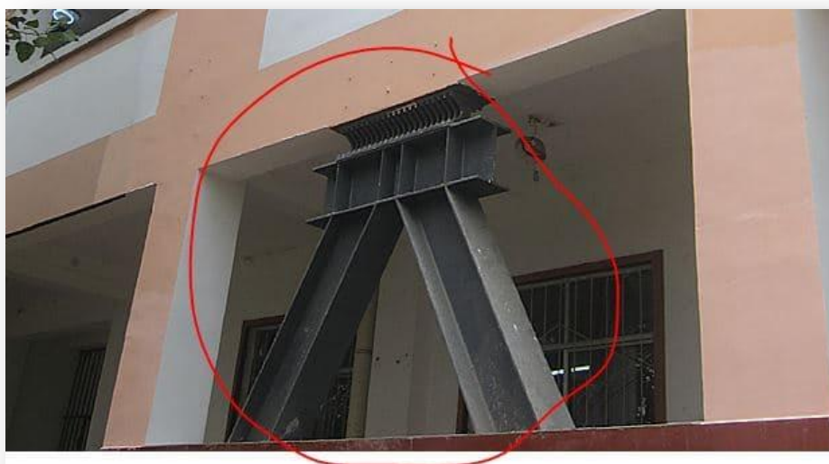
6-расм. Металл пайвандли демпферининг қаватлараро ўрнатилиши.
