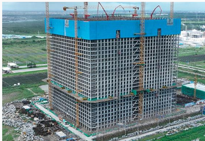
1.-rasm. Qayta tiklanuvchan energiya manbalari yordamida ishlab chiqarilgan energiyani Gravitatsion usulda saqlash
